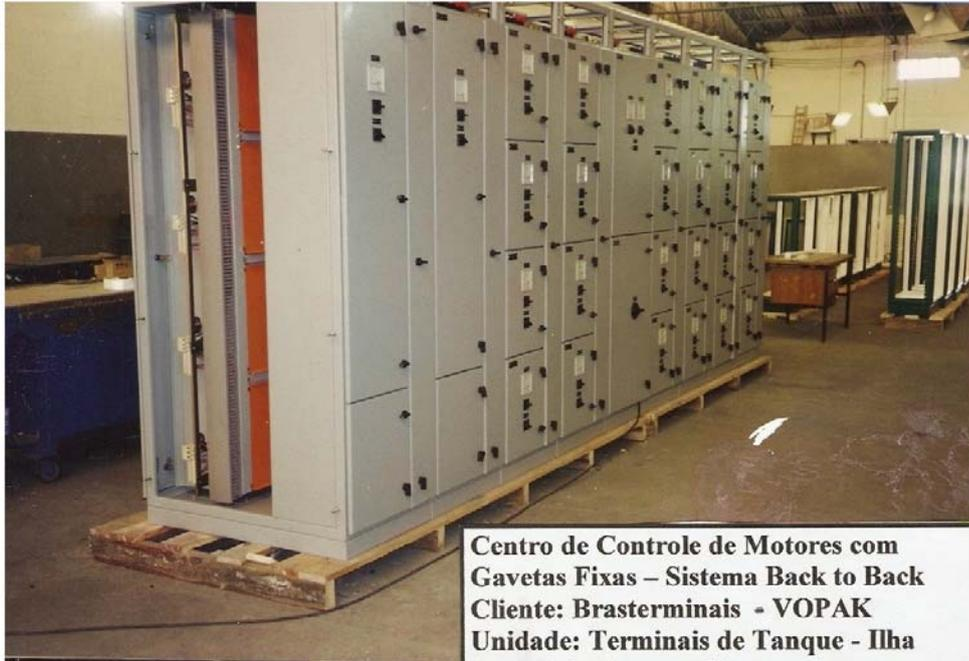
**Centro de Controle de Motores com Gavetas Fixas – Sistema Back to Back**
