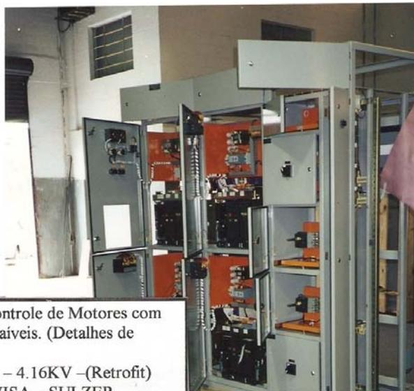
Centro de Controle de Motores com Gavetas Extraíveis. (Detalhes de Montagem)
